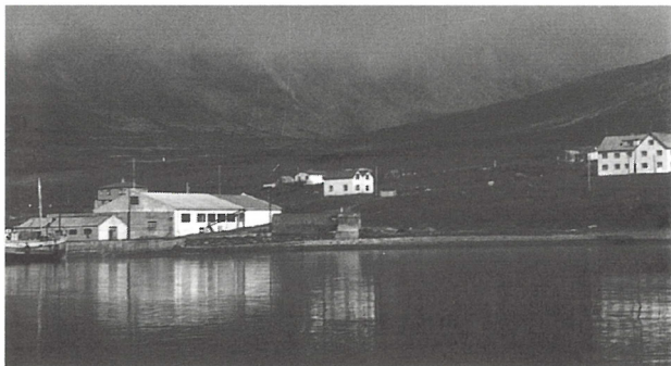
Gamla hraðfrystihúsið er brann í apríl 1957.
