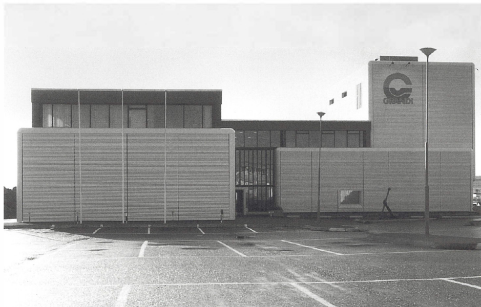
Frystihús Granda, Norður- gardur.
