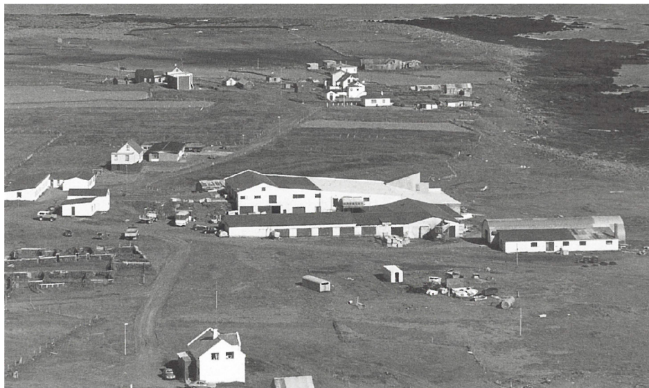
Hraðfrystihús Pórkötlustaða í Pórkötlustaðahverfi í Grindavík. Ljós.: Jón Karl Snorrason.
